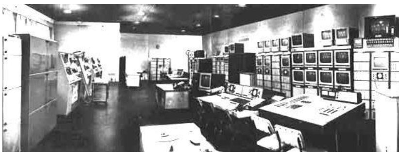
Рис. 1.2.22. Центральная техническая аппаратная для приёма, обработки и распределения ТВ информации с бортов космических кораблей «Союз-19» и «Аполлон» во время их совместного космического полёта в июле 1975 г.
