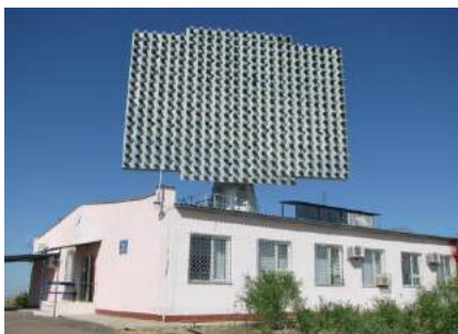
Рис. 3.4.19. Приёмная антенна космической связи на космодроме Байконур; эффективная площадь почти 200 м 2
