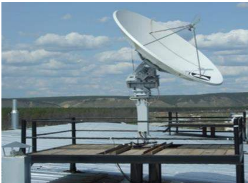
Рис. 3.7.2. Следящая за КА антенна ДМВ (HRPT, CHRPT, WEFAX) стационарного приёмного пункта «Сюжет-МФ» на позиции
