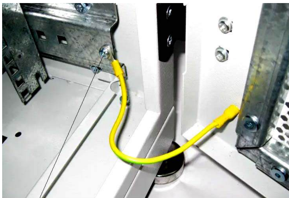
Винтовое соединение
